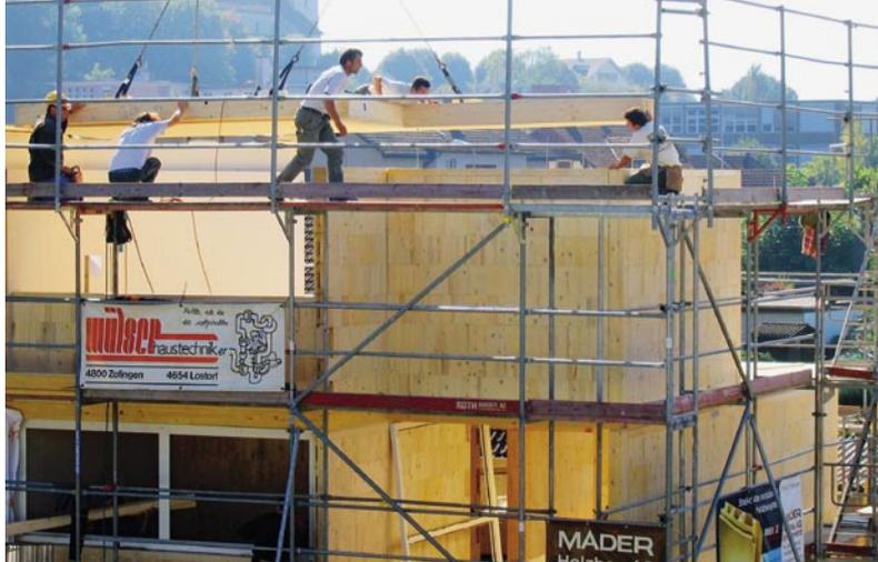
Die Geschossdecken wurden als Hohlkastenelemente in Holz konstruiert und angeliefert.
