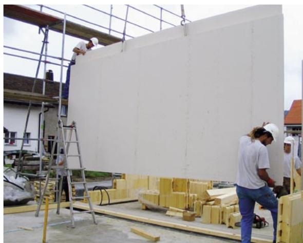
Die hinterlüftete Fassadenhaut ist in Chalet-Schalung mit Thermoholz ausgeführt (ganz links). Die Wohnungstrennwände wurden als Brandschutz-Wandelemente geschossweise versetzt.
